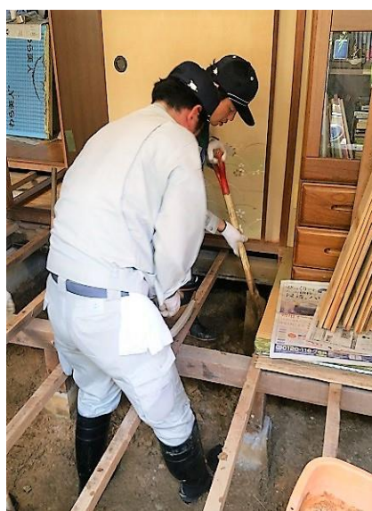
個人宅床下の泥出しの活動の様子
