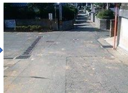
短期間で通行可能になった道路
